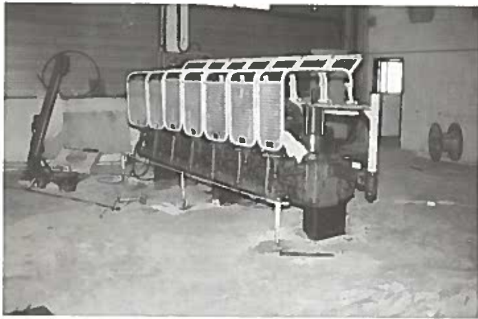
Nouvel atelier Fils. Réinstallation d'une machine.
