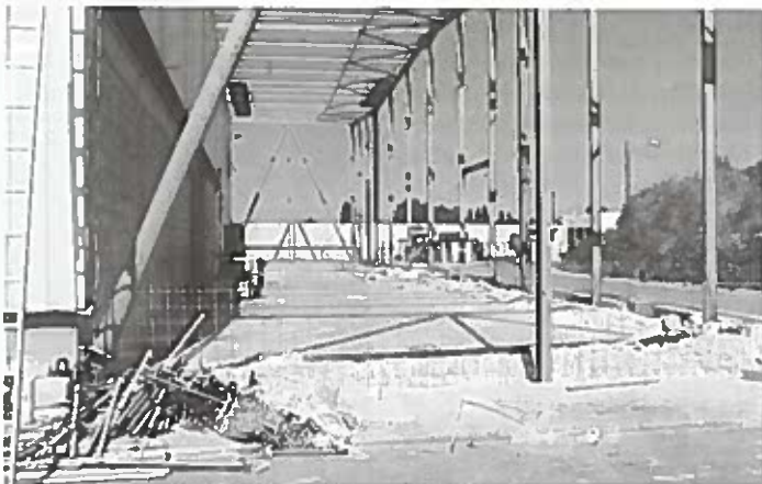
Construction du bâtiment magasin Arcap et Wiggin.
